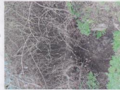
Arrivée des eaux de ruissellement de la route
